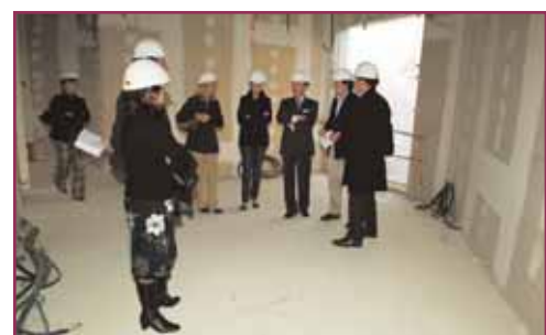
Visita a las obras de la futura Casa de la Juventud de Pozuelo
